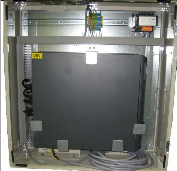
Die EVA-60-Light Einheit besteht aus einer starken USV-Einheit mit 3,5 kVA. Damit lassen sich Evakuierungsfahrten zur nächsten Haltestelle realisieren. Das Kabinenlicht, die Prozessreinheit und der geregelte 230VAC Türantrieb werden mitversorgt, so dass die Türen sich nach Beendigung der Fahrt öffnen.
